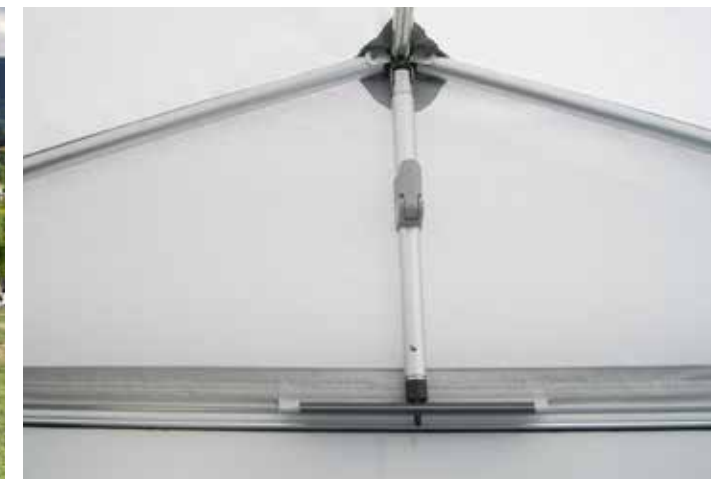
Unterstützung Dachspitze
